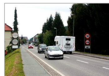
Fuß- und Radweg entlang B83
