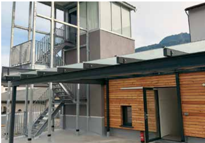
Schlauchturm und Terrassenbereich
