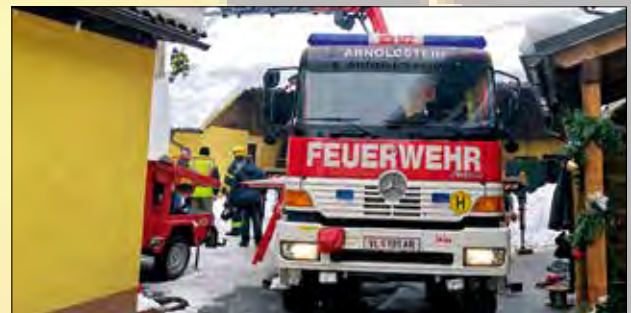
04. Jänner 2021; Wirtschaftsgebäude von der Schneelast befreien in Goritschach (MG Finkenstein), die Feuerwehr Arnoldstein unterstützt mit dem SRF.
