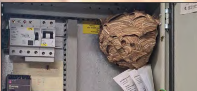
17. Juni 2022; Umsiedeln einiger Wespennester in Arnoldstein, die Feuerwehr Arnoldstein erledigt es
