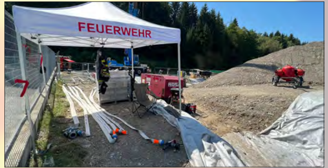
August 2023, Brandsicherheitswache bei der TAG Gasmess - Station in Agoritschach, die Wehren Siebenbrunn – Riegersdorf und Arnoldstein stehen im Einsatz
