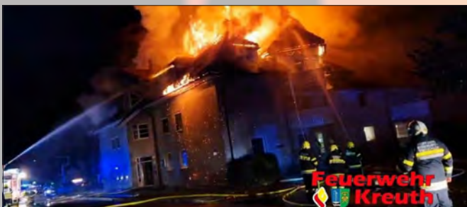
13. September 2023, Dachstuhlbrand beim Feuerwehrhaus in Kreuth, der Stützpunkt 1 steht mit der Drehleiter im Einsatz
