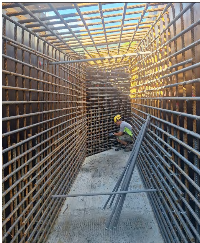
Geschieberückhaltesperre mit Armierungsführung
