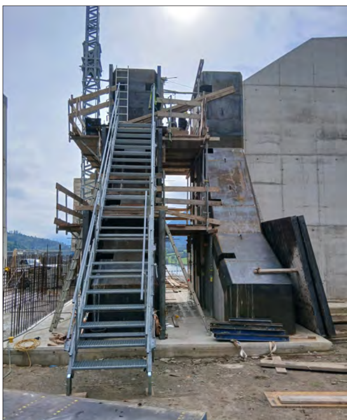
Gepanzerte Scheibenkonstruktion am Filterbauwerk
