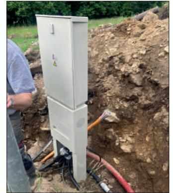
Nach der beschlossenen Vermessung und Grundabtretungen konnten die Arbeiten im Mai beginnen. Darüber hinaus wurden in diesem Bereich sämtliche Dachständer von mehreren Objekten für die Stromzuleitungen durch erdverlegte Hausanschlüsse ersetzt. Somit hat sich durch meine Intervention auch die Kelag an diesem Projekt beteiligt. Außerdem wurde ein Leerrohr für einen zukünftigen Glasfaseranschluss mitverlegt.
