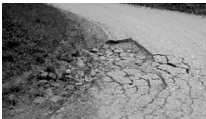
Teile unseres Straßennetzes sind im desolaten Zustand und werden saniert
