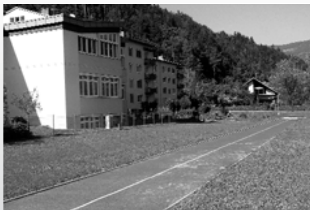
Die Laufbahn ist fertig gestellt
