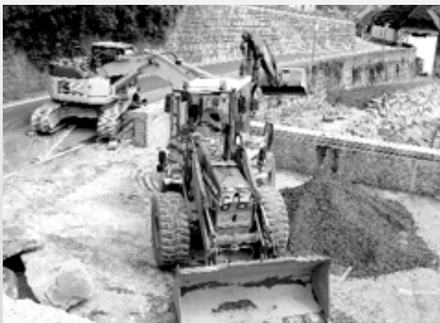
Die Arbeiten gestalteten sich als eher anspruchsvoll.
