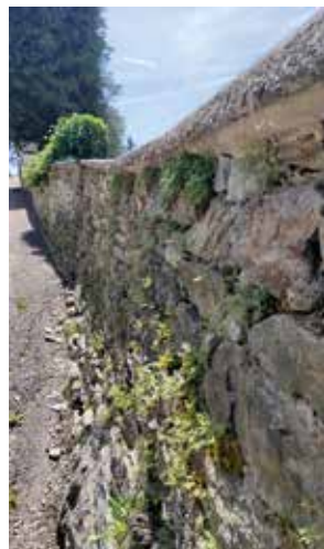
Die desolante Friedhofsmauer wird saniert
