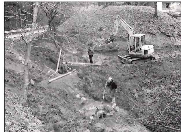
Bauarbeiten im Zuge des Kanalbaues
