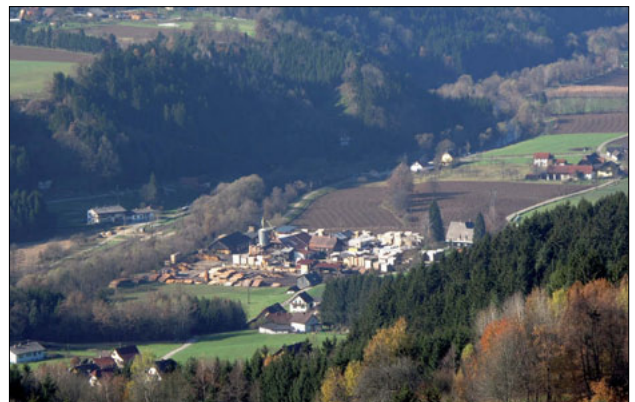
Ein Hochwasserschutzprojekt in Krottendorf ist im Mittelfristigen Finanzplan vorgesehen und bereits in Ausarbeitung
