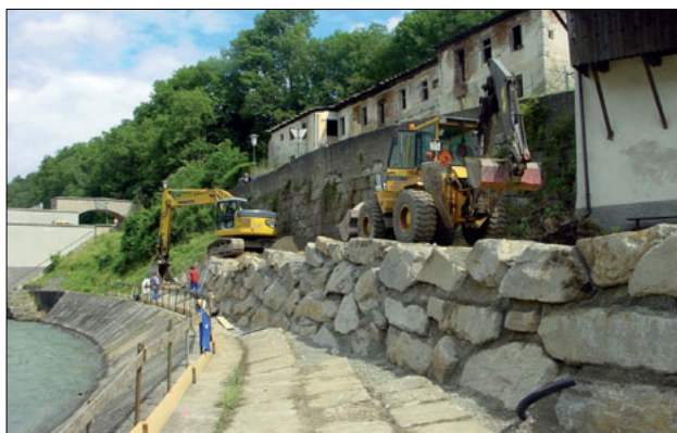
Ein Beispiel: Die Rampe unterhalb des Kraftwerkes Lavamünd wurde teilweise auf öffentlichem Wassergut errichtet
