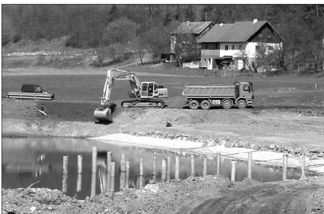
Die Böschungen und die Uferbereiche werden gestaltet
