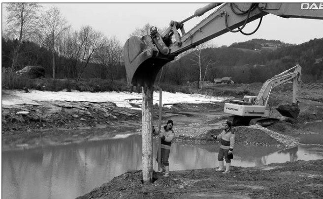
Das Einsetzen der Pfähle für den späteren Badesteg durch die Gemeindemitarbeiter
