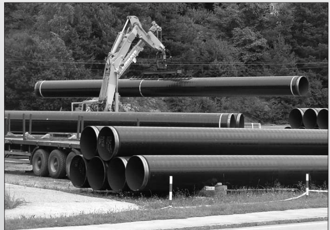
Abladen der Rohre von den Waggons am Staudachergelände
