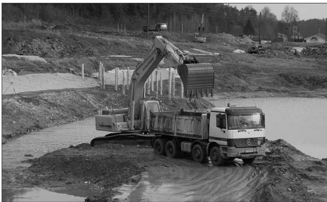
Der See wurde während den Bauarbeiten abgepumpt. So konnte die Vertiefung auf ca. 6 m durchgeführt werden
