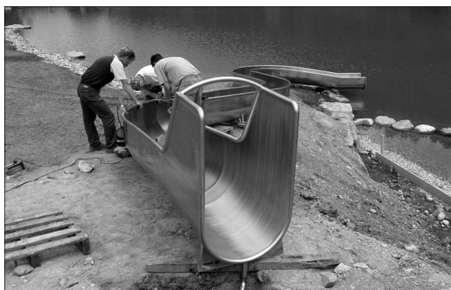
Einbau der Wasserrutsche durch den Wirtschaftshof und den Lieferanten
