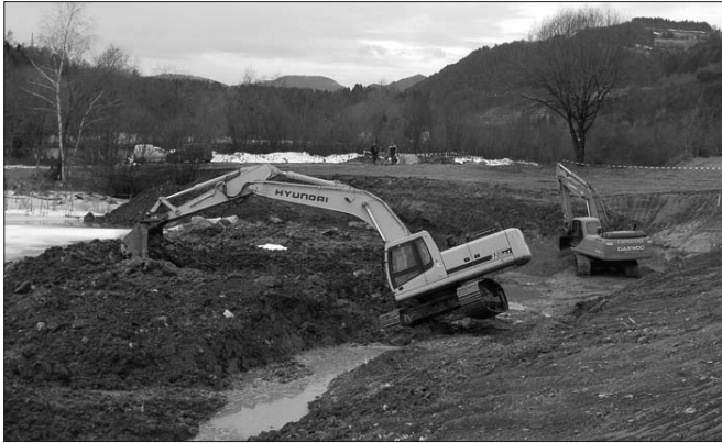
Baggerungsarbeiten im Winter
