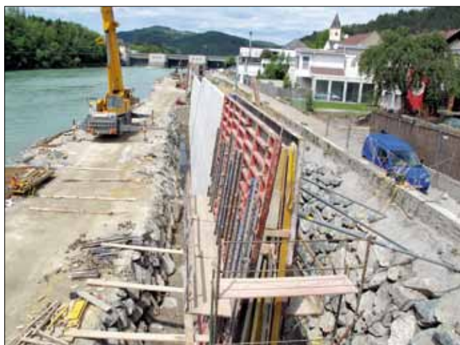
Die Bauarbeiten bei der Hochwasserschutzmaßnahme schreiten voran.
