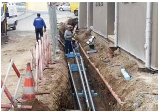
Im Zuge dieser Arbeiten wird auch eine Fernwärmeleitung mitverlegt – hier Bereich Kulturhaus
