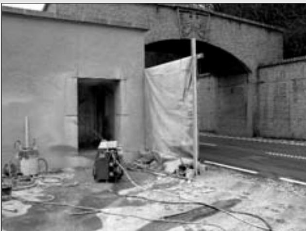
Das Kraftwerkshaus wird durchbrochen und künftig ein Durchgang durch das Gebäude führen
