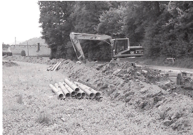
Kanalbau in der Marktgemeinde Lavamünd - ein Großprojekt
