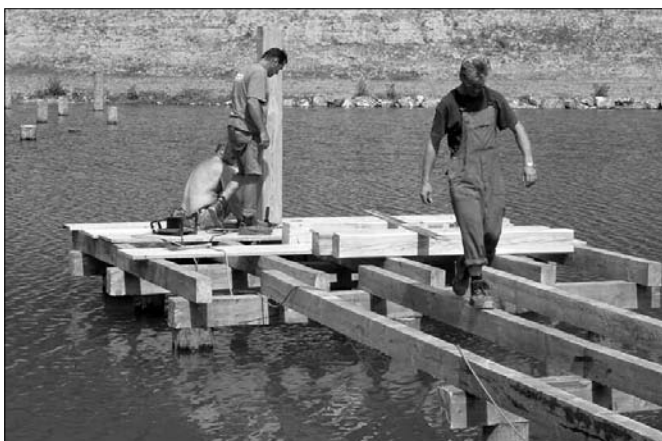
Ein Badesteg mit Sprungturm wurde vom Wirtschaftshof errichtet.
