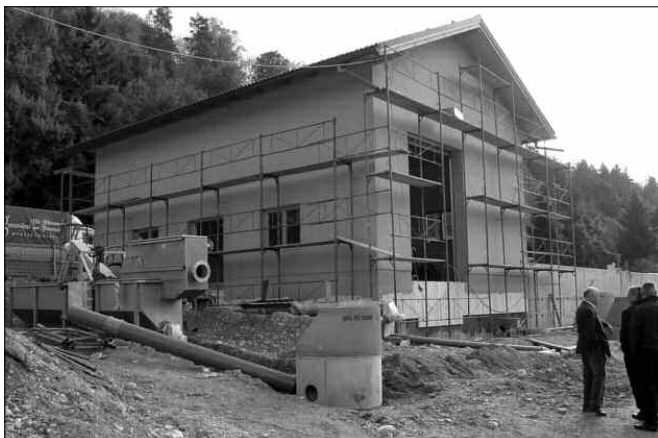
Zeitlich gut gewählt wurde der Bau der Kläranlage und der Kanalisation.
