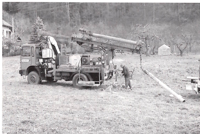
Probebohrungen gaben Aufschluss über den Untergrund beim Badeteich
