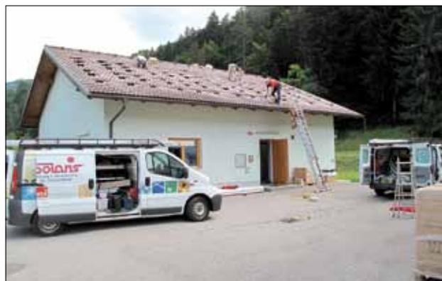
Auf den Dächern der Kläranlage wird eine 23 kWp-Anlage errichtet
