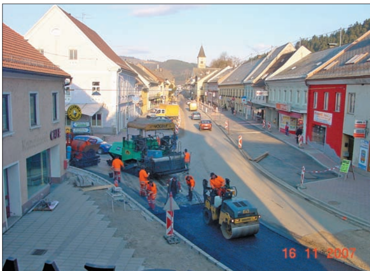
Asphaltierungsarbeiten im Zuge der Ortsplatzgestaltung
