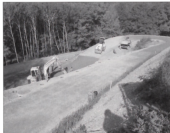
Bau der Serpentina am R1 unmittelbar vor der Staatsgrenze
