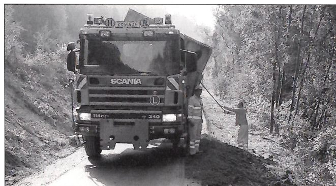
Mitarbeiter der Straßenmeisterei bei Humusierungsarbeiten am R1
