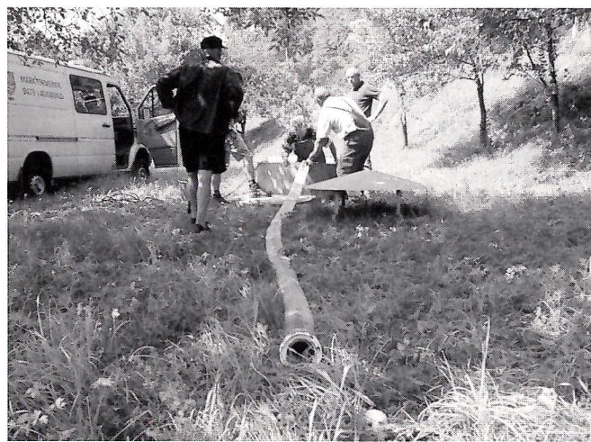
Derzeit werden Vorbereitungen für die Bohrung eines Tiefbrunnens im Freizeitgelände am Sportplatz durchgeführt. Probeentnahmen sowie Quellmessungen am Grundwasser erfolgen durch die Mitarbeiter unseres Wirtschaftshofes.
