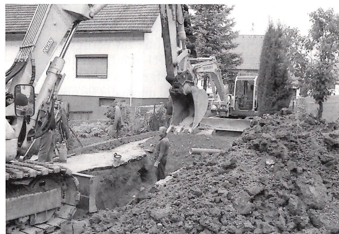
Bauarbeiten im Zuge des Kanalbaues in Schwarzenbach
