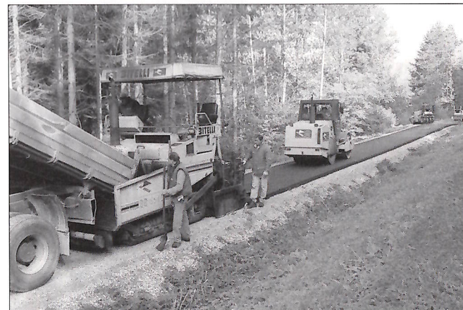
Asphaltierungsarbeiten entlang des Radweges R1
