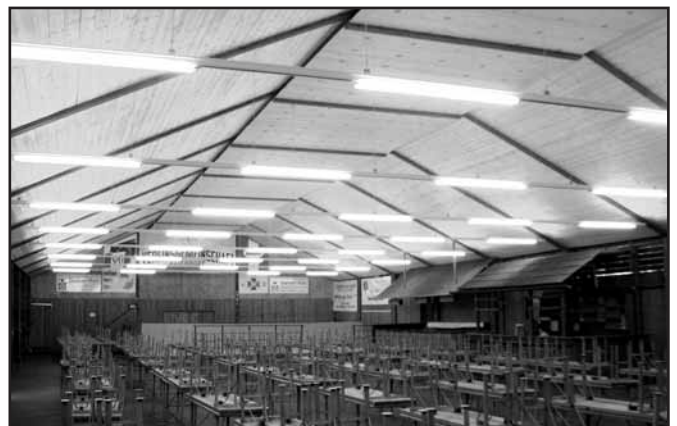
Nach Fertigstellung der Arbeiten
