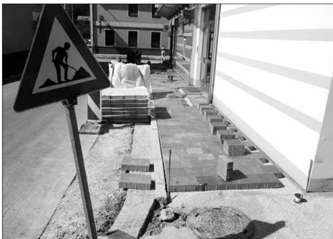
Die Pflasterungsarbeiten und Asphaltierungsarbeiten sind abgeschlossen
