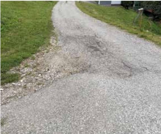
Mit diesen Mitteln werden wir heuer einen wichtigen Abschnitt am hinteren Lamprechtsberg instand setzen. Auf einer Länge von rund 300 Metern wird die Fahrbahn durch eine Zementstabilisierung nachhaltig saniert. Diese Methode erhöht die Tragfähigkeit der Straße und sorgt für eine deutlich längere Haltbarkeit, was allen Verkehrsteilnehmern zugutekommt.
