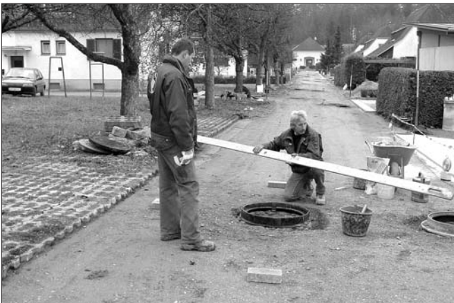
Die Kanalbauarbeiten in Wunderstätten stehen vor dem Abschluss
