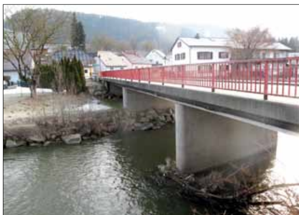
Foto: Die Lavantbrücke wird neu errichtet
