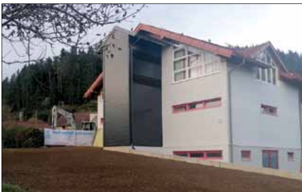
Die Errichtung des Schlauchturms beim Rüsthaus Ettendorf ist abgeschlossen. Das neue Kleinlöschfahrzeug hat der Gemeinderat beschlossen.
