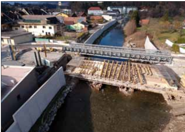
Der Bau des Hochwasserschutzes im Ort Lavamünd verläuft im Zeitplan.
