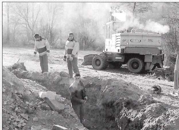
Grabungsarbeiten im Freizeitzentrum
