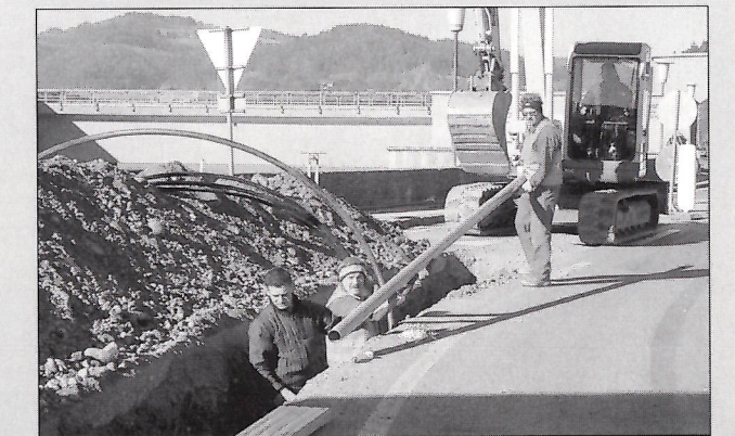
Verlegung des Stromkabels und der Kanalleitung ins Freizeitzentrum durch den Wirtschaftshof, Fa. Ninaus und KELAG
