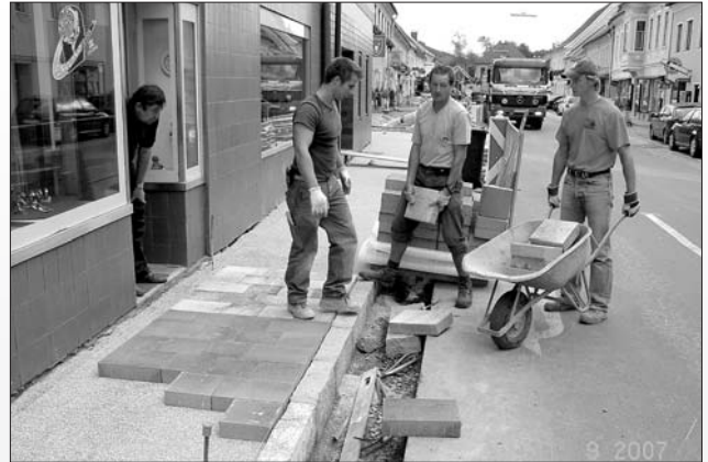
Durch den eingebauten Drainagebeton unterhalb der Gehsteig-Pflasterung ist eine große Stabilität für die nächsten Jahrzehnte gewährleistet. Der Einbau erfolgte durch die Fachleute der Firma Alpine.
