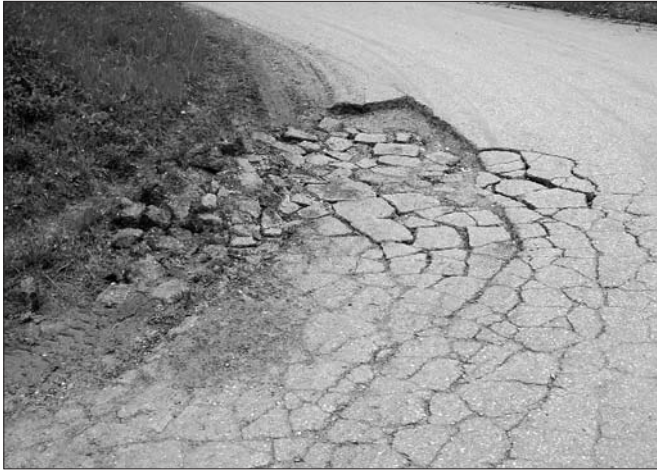
Verschiedene Straßensanierungsarbeiten stehen an
