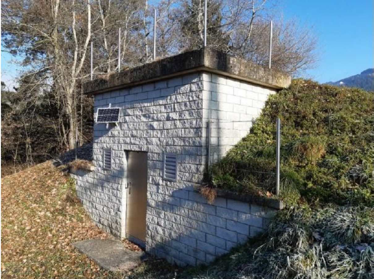
Foto: Hochbehälter Magdalensberg (oberhalb Hüttenwirt)
