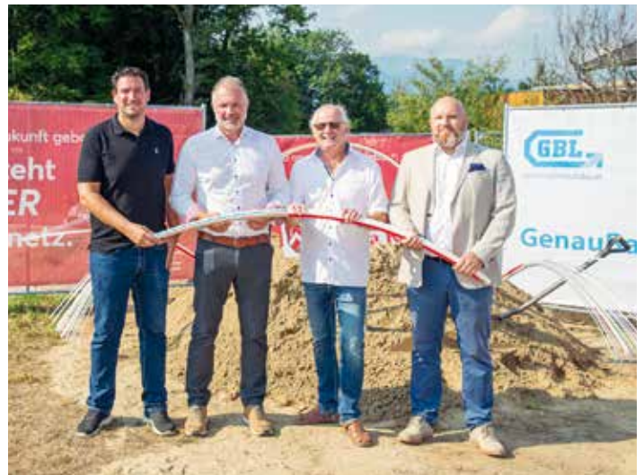
Patrick Karasin (öGIG Projektleiter), Vizebürgermeister Edgar Kienleitner, Bürgermeister Franz Ragger und Vjacheslav Paramonovs (Geschäftsführer GenauBauLeistungen) beim offiziellen Spatenstich zum öFIBER Glasfaser-Ausbau in Maria Rain.
