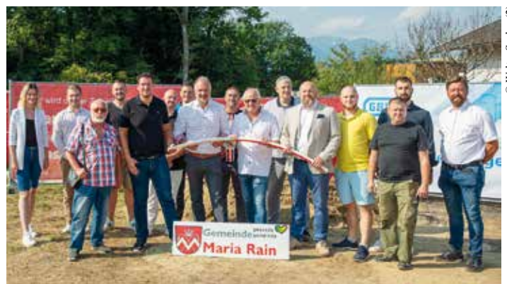
Vertreterinnen und Vertreter der Firma öGIG, GenauBauLeistungen und CCE gemeinsam mit Bürgermeister Franz Ragger sowie Vizebürgermeister Edgar Kienleitner beim symbolischen Spatenstich in Maria Rain.
