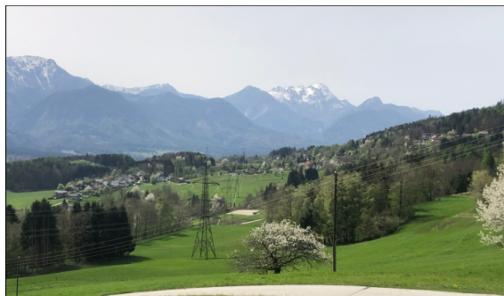
Blick auf das Siedlungsgebiet von Pugrad mit dem Dorfkern (rechts), der querenden 220-kV-Leitung und einer Einfamilienhausssiedlung aus neuerer Bauperiode (links)
