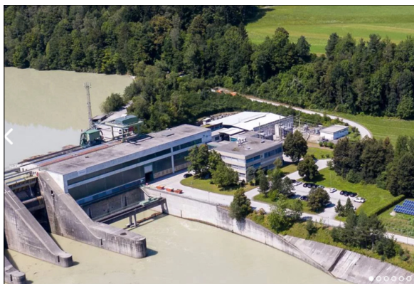
Draukraftwerk Feistritz-Ludmannsdorf (Quelle: Verbund)
