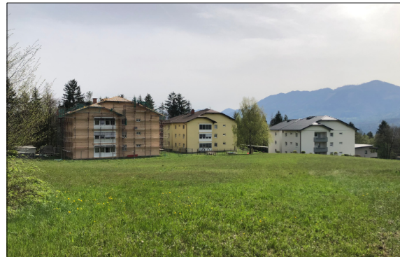
Geschoßwohnanlagen im nördlichen Siedlungsbereich von Edling
