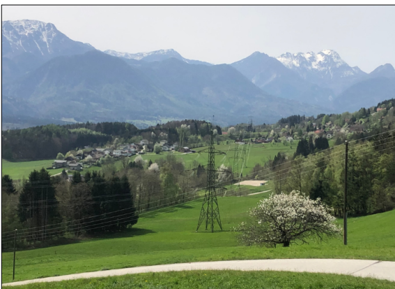
220-kV-Hochspannungsfreileitung bei Pugrad
