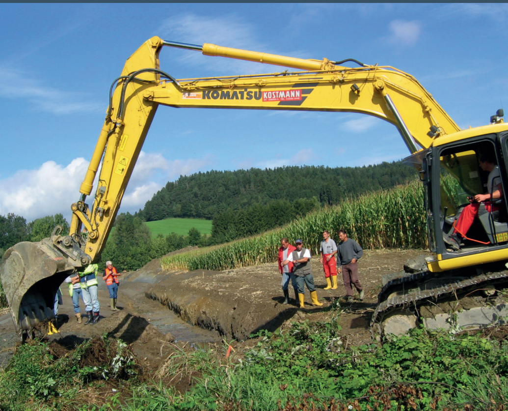
Naturschutzfachkräfte auf der Baustelle
